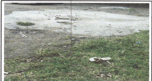
reparación de plancha de concreto de patio
