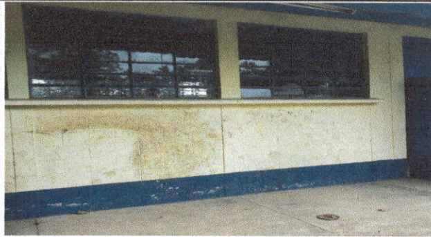
pintura en muros exteriores e interiores
