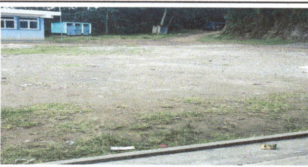
reparación de plancha de concreto de patio
