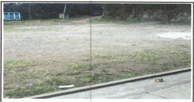
reparación de plancha de concreto de patio
