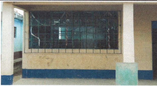
pintura de muros exteriores e interiores
