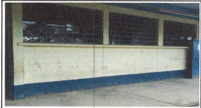
pintura en muros exteriores e interiores
